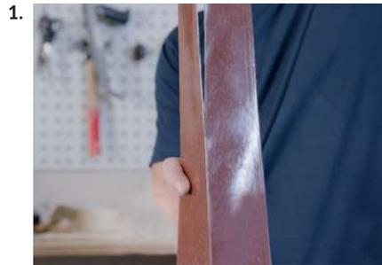
Das Brandschutzgewebe ist werkseitig mittig vorgeschlitzt. Bandage ablängen und entlang der vorgeschlitzten Linie mit einem Cuttermesser oder Schere mittig teilen. Bei Einbau in Decken wird der Wickel nicht geteilt.
