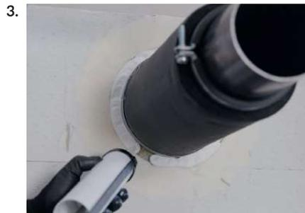
Ringspalt verschließen, z. B. mit: NOVASIT BM oder GFM Brandschutzmörtel, Beton, Zementmörtel, Gips oder Mineralwolle + FLAMMOTECT-A
