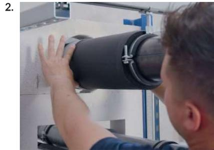
Je Bauteilseite eine Bandagenhälfte so anordnen, dass 15 mm – entspricht der Zollstockbreite – aus dem Bauteil hervorstehen und mit Klebeband fixieren.
